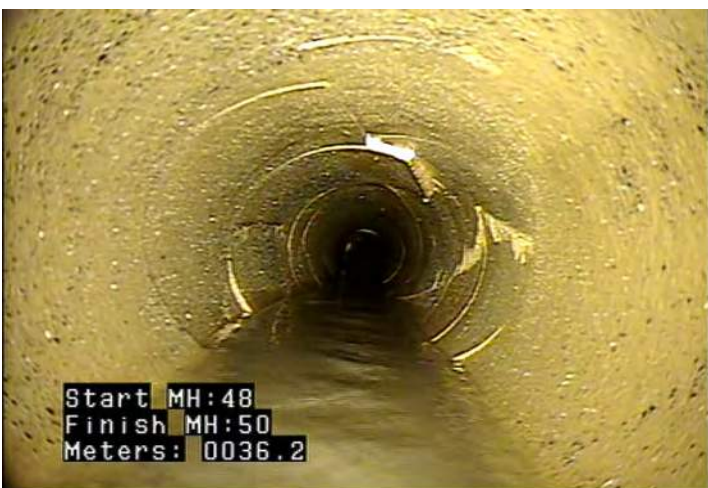
B - Pipe Broken @ 36.2 m.
