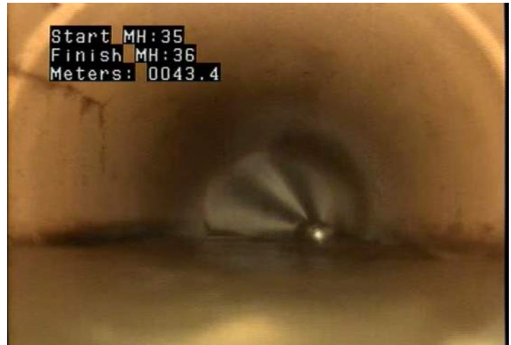
CL - Crack Longitudinal @ 43.4 m.
