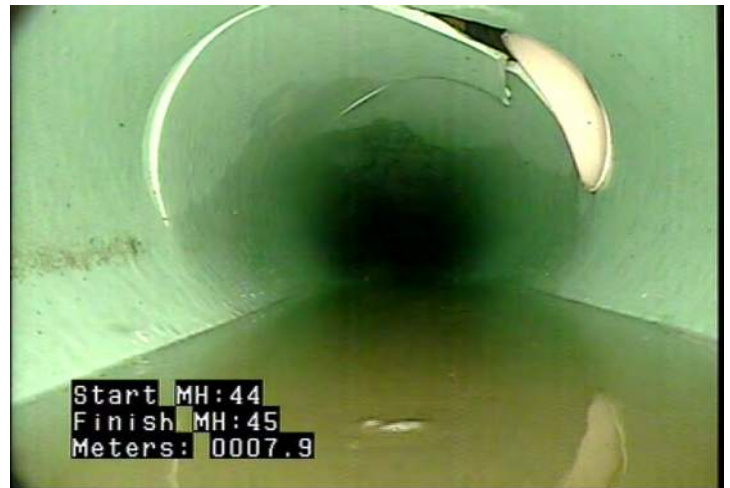
B - Pipe Broken @ 8.1 m.
