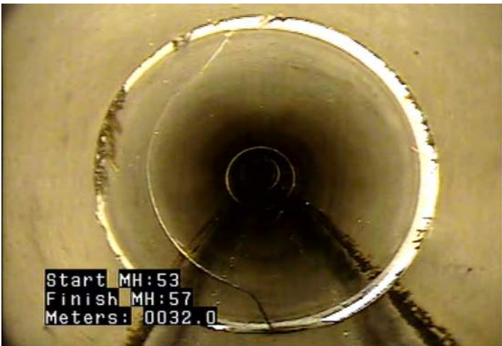
FS - Fracture Spiral @ 32.0 m.
