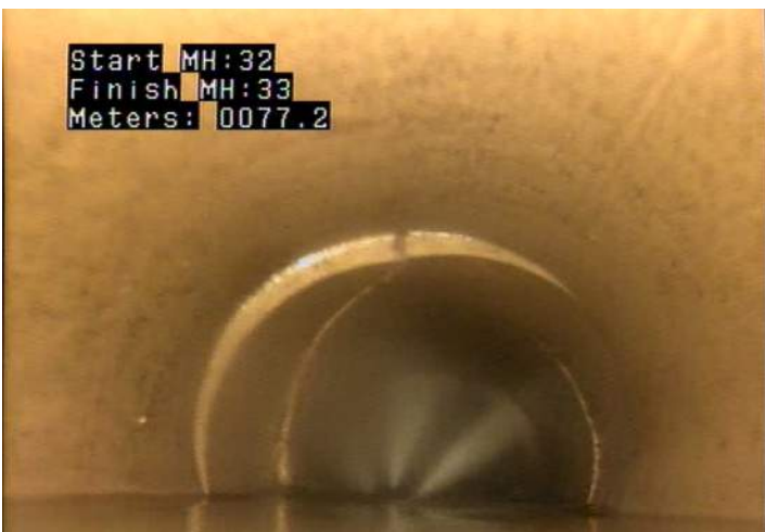
B - Pipe Broken @ 77.2 m.
