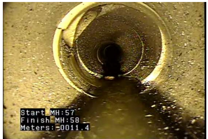
B - Pipe Broken @ 11.4 m.
