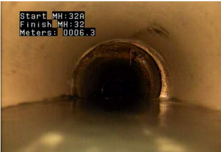
CL - Crack Longitudinal @ 6.3 m.
