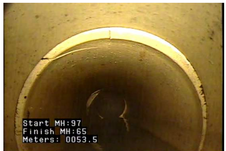
FS - Fracture Spiral @ 53.5 m.
