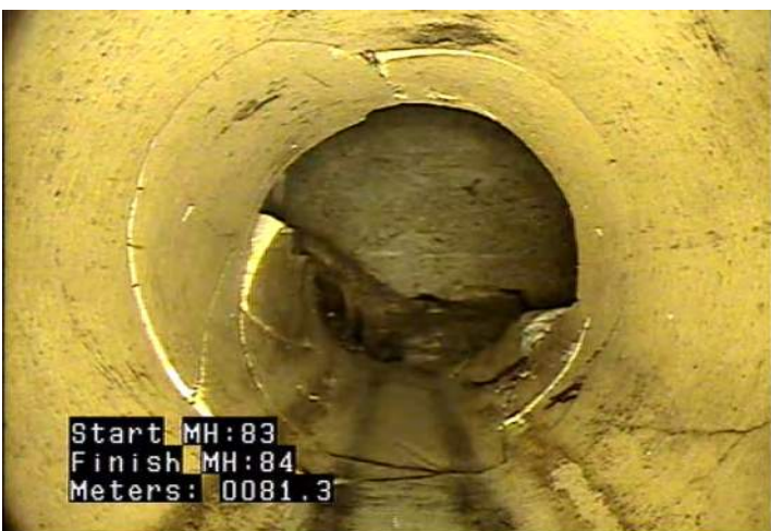
B - Pipe Broken @ 81.3 m.
