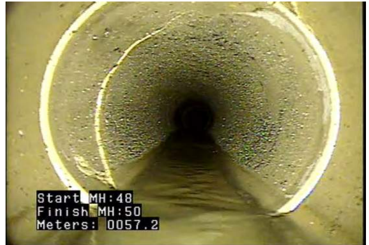
FS - Fracture Spiral @ 57.2 m.
