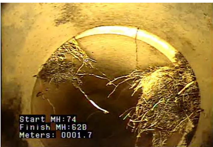
CL - Crack Longitudinal @ 1.7 m.
