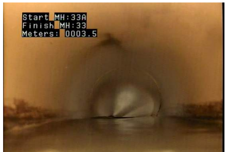
CL - Crack Longitudinal @ 3.5 m.
