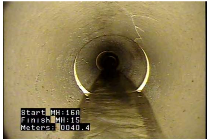
CL - Crack Longitudinal @ 40.4 m.
