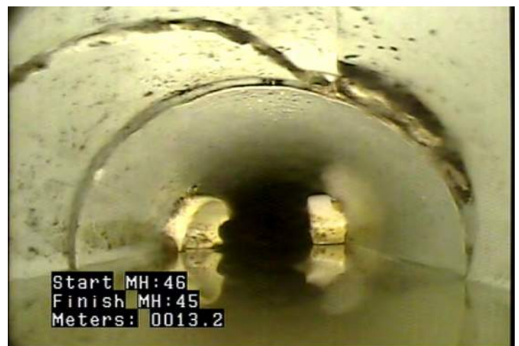
B - Pipe Broken @ 13.2 m.
