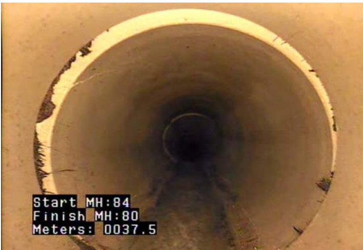
CL - Crack Longitudinal @ 37.5 m.
