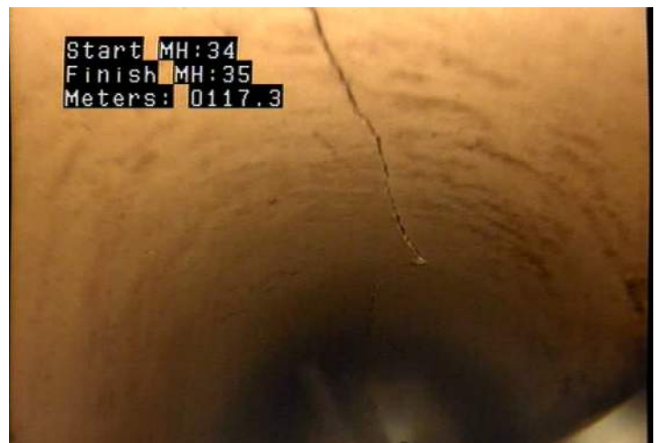
FL - Fracture Longitudinal @ 117.3 m.
