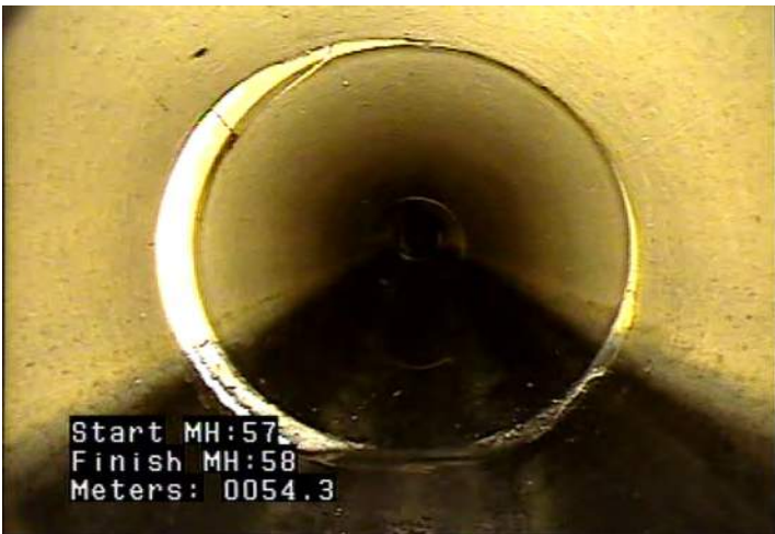
FS - Fracture Spiral @ 54.3 m.
