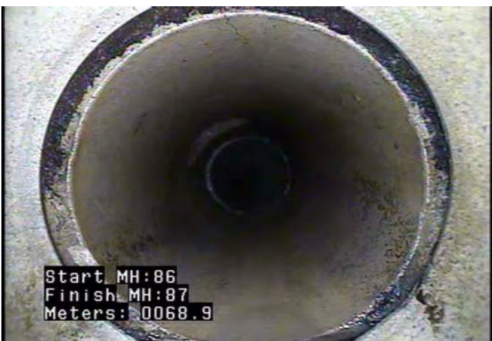
CL - Crack Longitudinal @ 68.9 m.
