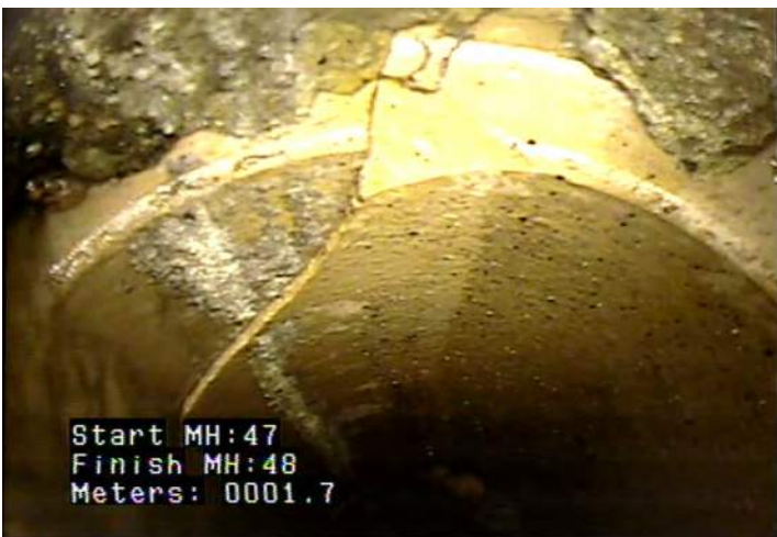
B - Pipe Broken @ 0.5 m.
