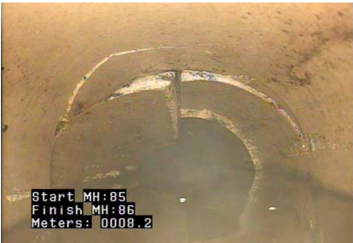
B - Pipe Broken @ 8.2 m.
