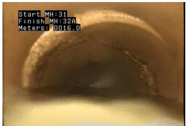
B - Pipe Broken @ 16.0 m.
