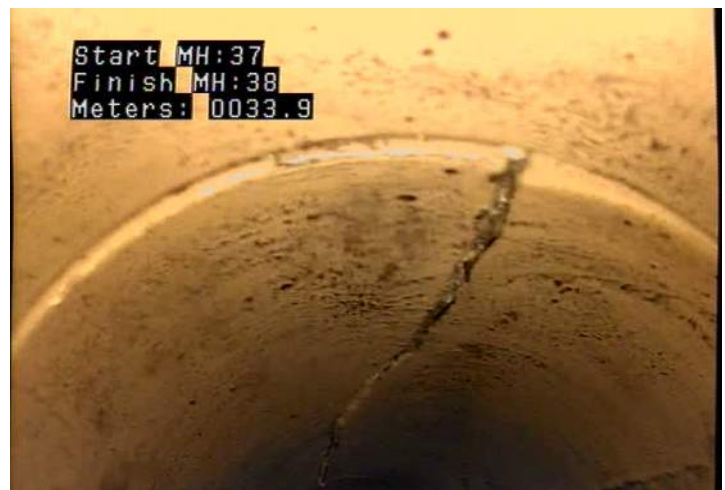
B - Pipe Broken @ 33.9 m.
