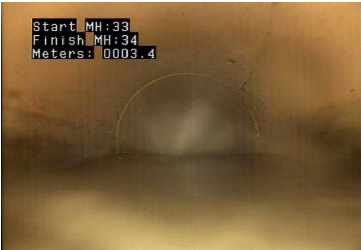
CL - Crack Longitudinal @ 3.4 m.
