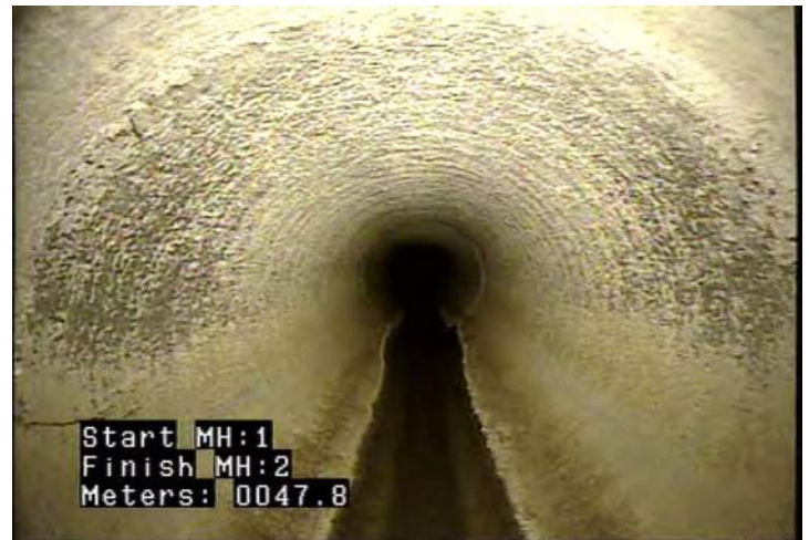
CL - Crack Longitudinal @ 47.8 m.
